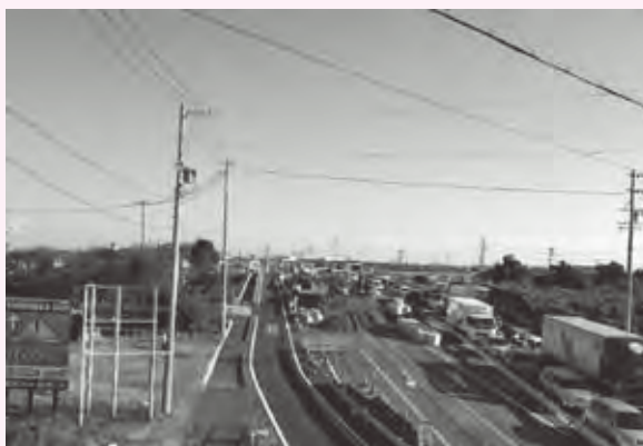
〈急ピッチで整備が進む、県道焼津森線〉 （仮宿交差点より焼津方面を望む）
