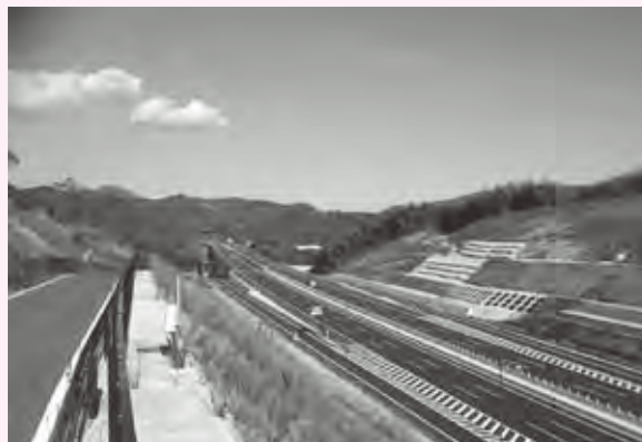
〈新東名側道より東京方面を望む〉
