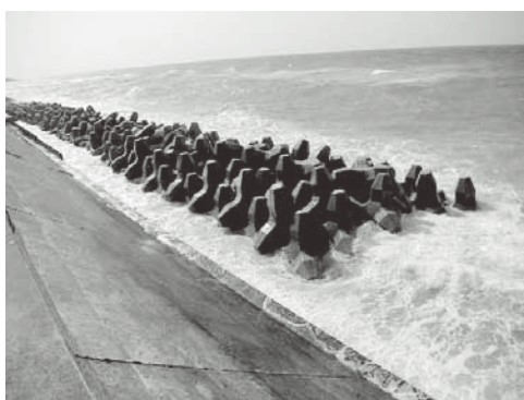
ねがためこう 根固工により防潮堤を保護 (海岸防災林地内)
