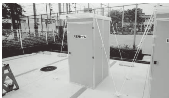
トイレ機能喪失への緊急的な対応として、 地震災害時用下水道接続型仮設トイレ (マンホールトイレ)の整備(高校の敷地内)
