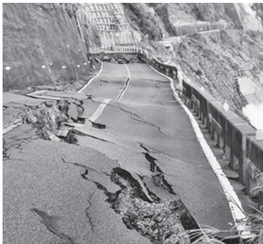
道路面に約 1 m の段差が生じ、通行不能に。
