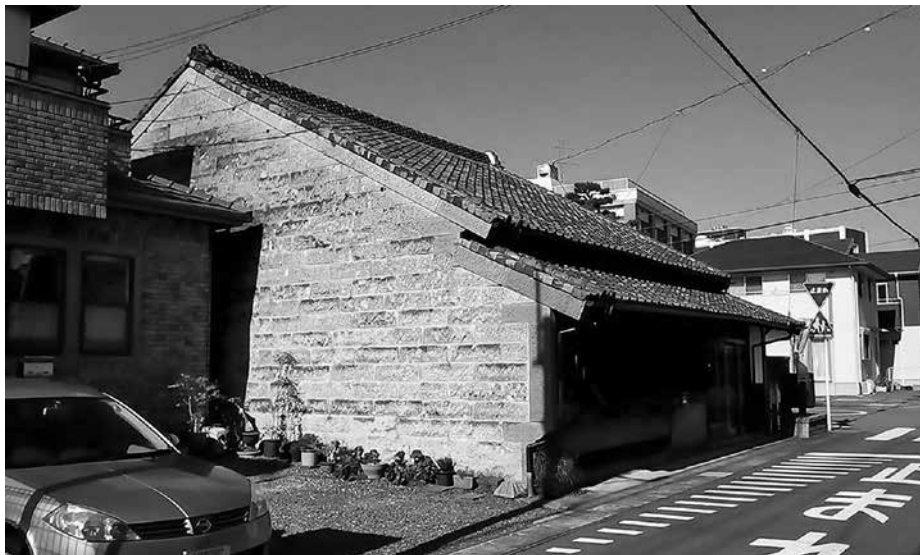
焼津市内の古い土蔵や民家には、今も伊豆石を使用した建物があります。往時、駿河湾の交易が活発であったことの名残のように感じます。
